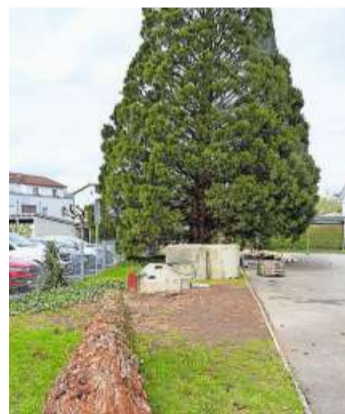
Im Zuge der Bauarbeiten wurde ein Mammutbaum gefällt.
