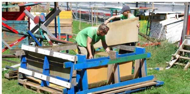
Die Hitzeperiode anfangs der Sommerferien veranlasste Lukas Hink und Martin Zampieri zum Bau eines Pools – aus Abfallprodukten. Reste von Plexiglasständern aus den USA bildeten die seitlichen Stützen, alte Schaltafeln den Boden und nicht mehr ganz taufrische Spanplatten die Seitenwände.
